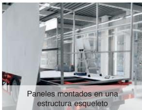
Paneles montados en una estructura esqueleto
