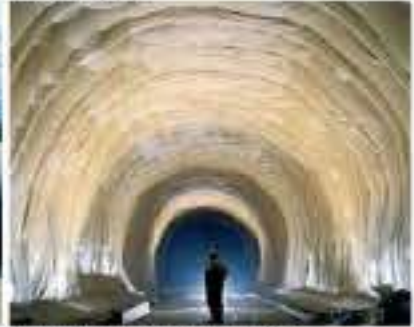
Impermeabilización de túnel
