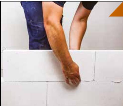
**FIJACIÓN 60 Segundos** es una solución resistente y duradera para la construcción de paredes divisorias. Puede utilizarse en paredes sin carga con bloques de hormigón calibrados o ladrillos de arcilla siempre calibrados. Ésta pared divisoria podría ser decorada con yeso u otro material tan sólo una o dos horas después.
