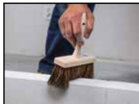
Antes de aplicar la primera capa de FIJACIÓN 60 Segundos asegúrese de que las superficies a fijar son planas y parejas. Siga las instrucciones de preparación de la superficie para una unión firme y duradera. Primero mida la distancia de la pared diseñada y planifique cómo se van a colocar los bloques o ladrillos. Con el objetivo que la pared esté perfectamente nivelada y aplomada, es necesario que la primera capa de pared se realice con mortero tradicional.
