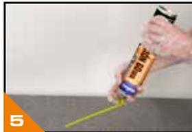
5 El producto debe utilizarse con el envase en posición invertida y en zonas bien ventiladas. Regulemos la dosificación mediante la presión del gatillo de la cánula.
