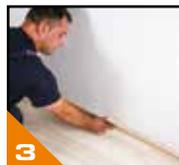
Aplique un cordón serpentino de adhesivo a lo largo del molde. Asegúrese de que hay suficiente margen entre el cordón del adhesivo y el borde de la moldura para evitar que rebose en la pared o el suelo. Se recomienda aplicar un cordón fino ~ 1 cm.
