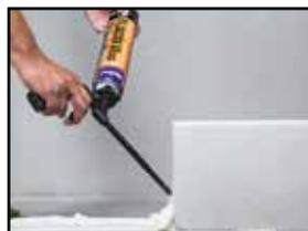
Los cordones se deben aplicar en la parte superior de la pared, no en los ladrillos sueltos antes de colocarlos. Aplique suficiente adhesivo para pegar no más de 2-3 ladrillos.
