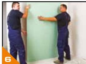
**6** Utilice un nivel para colocar el tablero. Presione fuerte para asegurarse de que el espacio entre la placa y la pared no sea mayor de 1 cm, de lo contrario, podría producirse una expansión del adhesivo. Mientras que el adhesivo termina de curar en la primera tabla, vaya aplicando en la siguiente usando el mismo patrón y después, fíjelo en la pared.
