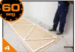
**3** Comenzaremos por el perímetro del tablero: Mantenga una distancia de 4 cm del borde para evitar que el adhesivo rebose cuando las superficies estén unidas. A continuación, aplique un cordón en zigzag de adhesivo partiendo de una de las esquinas del cordón perimetral. El cordón perimetral debe dejar una pequeña zona abierta para permitir el paso del aire y el curado del adhesivo sea el adecuado, según se ve en la foto.
