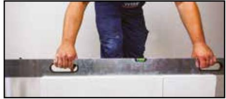
Dispone de 1 minuto para corregir la posición de los ladrillos. Fijación 60 Segundos seca rápido, así que asegúrese de colocar inmediatamente el ladrillo o bloque en su posición final. Cuando haya terminado con la primera capa de ladrillos, puede comenzar inmediatamente a colocar la siguiente capa.
