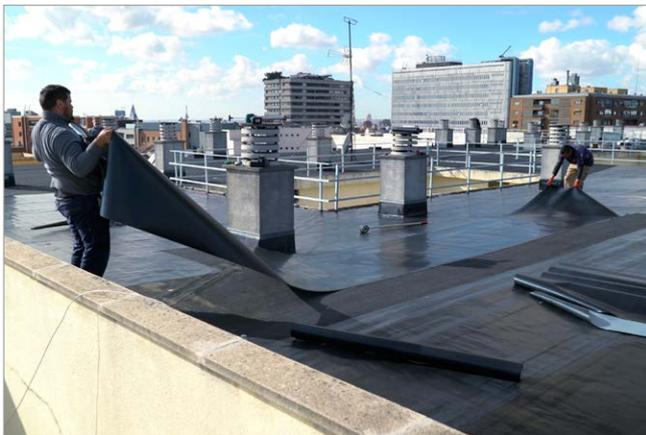
Mida cuidadosamente la superficie a impermeabilizar y corte la lámina de EPDM Rollgum Fix al tamaño adecuado, teniendo en cuenta solapes entre láminas (mínimo 10 cm), remotes perimetrales, solapes alrededor de chimeneas, aberturas de ventilación, claraboyas, etc.
