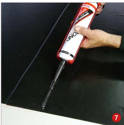
1 Solape las láminas Rollgum Fix un mínimo de 10 cm y realice una línea discontinua en el borde para identificar hasta donde aplicar la imprimación.
