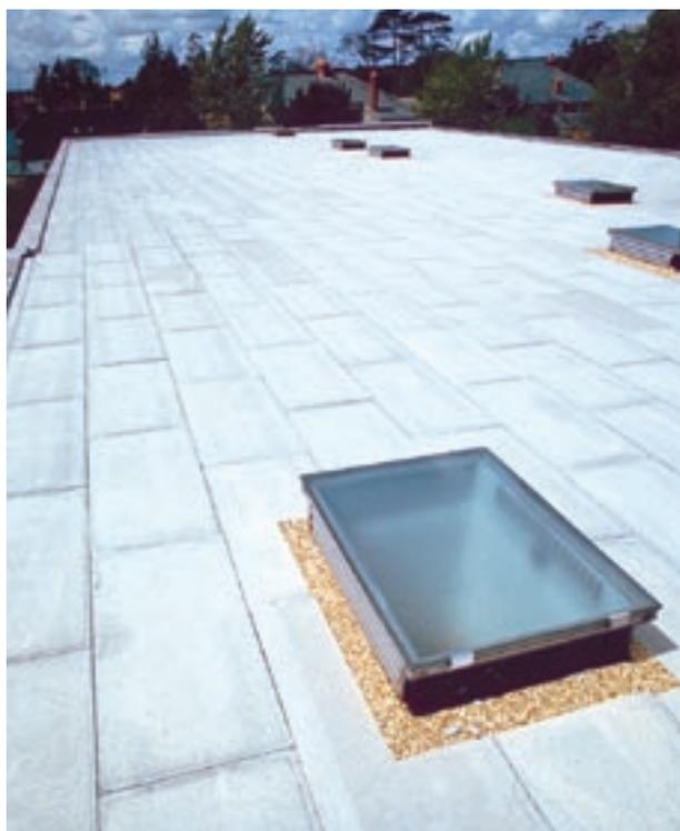
En las entregas a puntos singulares donde la cubierta queda perforada (lucernarios, sumideros, chimeneas, etc.), las baldosas aislantes ROOFMATE LG-X pueden ajustarse mediante cortes y orificios practicables con sierra radial. Se dejara una junta con holgura de unos 5 mm (**figura 15**).
